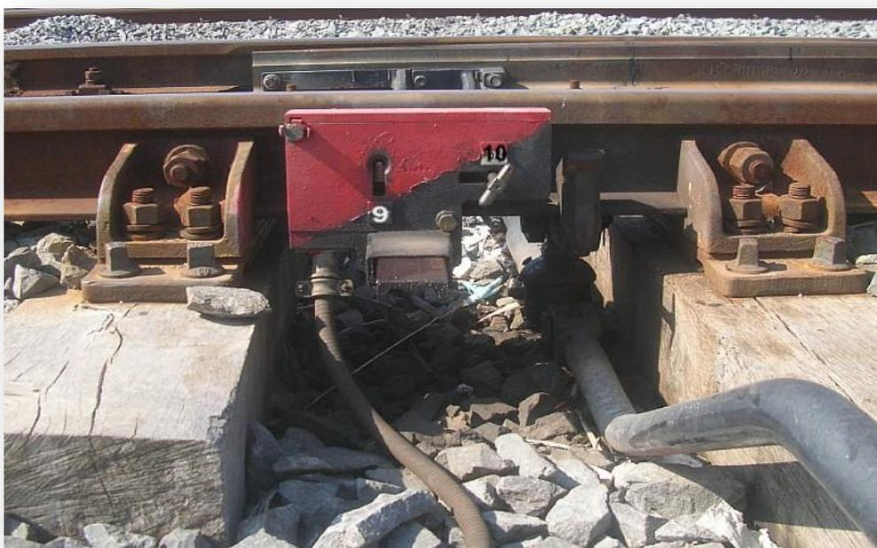
*Inseriamo la chiave marca 9 nell'apposita toppa: ruotandola sarà possibile sia manovrare il deviatoio che estrarre la chiave marca 10, che si trova imprigionata nel fermadeviatoio.*
